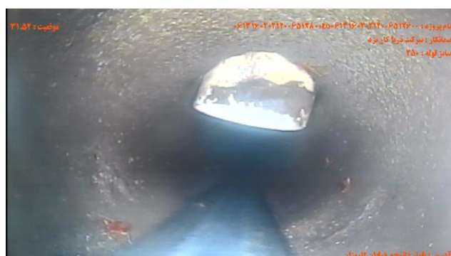
شماره تصویر ۴ عنوان اتصال جانبی معيوب/انشعاب مهاجم- نفوذ به داخل لوله موقعیت ۳۱.۵۲ کد CXI درصد ۱۰
