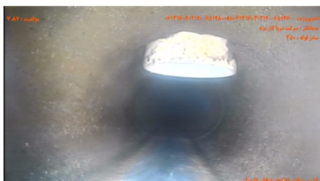
شماره تصویر ۳ عنوان اتصال جانبی معيوب/انشعاب مهاجم- نفوذ به داخل لوله موقعیت ۷.۸۷ کد CXI درصد ۱۰
