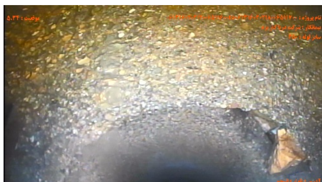
شماره تصویر ۳ عنوان سوراخ / سوراخ در دیواره فاضلابرو موقعیت ۵۰۴ کد H
