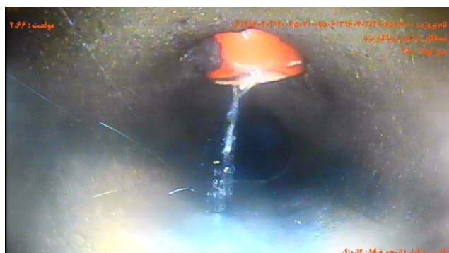
شماره تصویر ۳ عنوان اتصال جانبی معيوب / انشعاب مهاجم- نفوذ به داخل لوله موقعیت ۲۰۶۶ کد CXI
