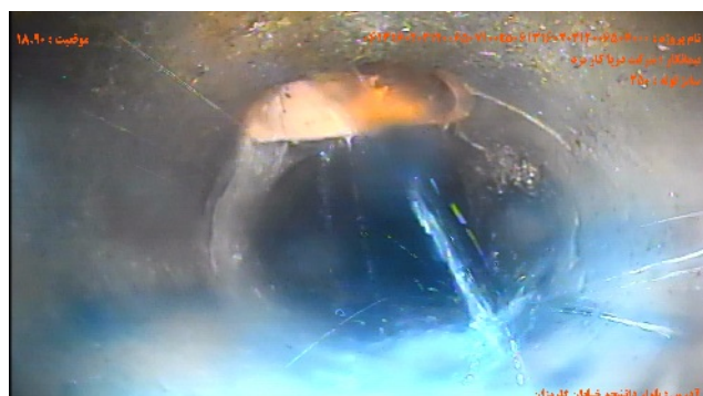
شماره تصویر ۴ عنوان محل اتصال انشعاب / اتصال انشعاب موقعیت ۱۸۰۹۰ کد CN
