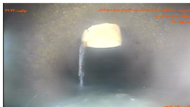
شماره تصویر ۴ عنوان اتصال جانبی معيوب / اتصال معيوب اشعاب موقعیت ۳۷۰۷ کد CX
