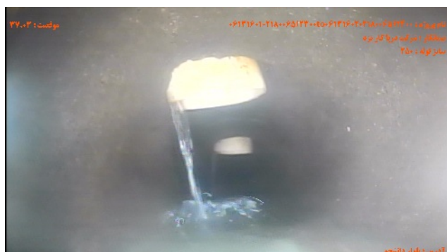
شماره تصویر ۳ عنوان اتصال جانبی معيوب / اتصال معيوب اشعاب موقعیت ۳۷۰۳ کد CX
