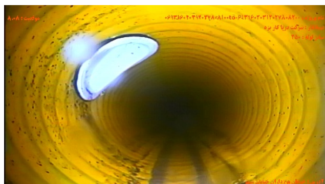
شماره تصویر ۴ عنوان محل اتصال انشعاب / اتصال انشعاب موقعیت ۸۰۰۸ کد CN
