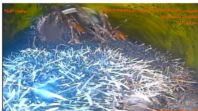
شماره تصویر ۹ موقعیت ۴۵.۵۴ کد CX عنوان اتصال جانبی معيوب/اتصال معيوب انشعاب
