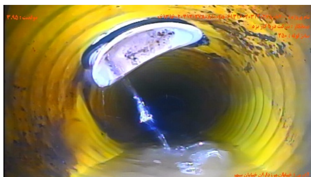
شماره تصویر ۳ عنوان اتصال جانبی معيوب / اتصال معيوب انشعاب موقعیت ۳۰۹۵ کد CX
