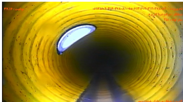
شماره تصویر ۷ موقعیت ۳۷.۱۶ کد CN عنوان محل اتصال انشعاب/اتصال انشعاب
