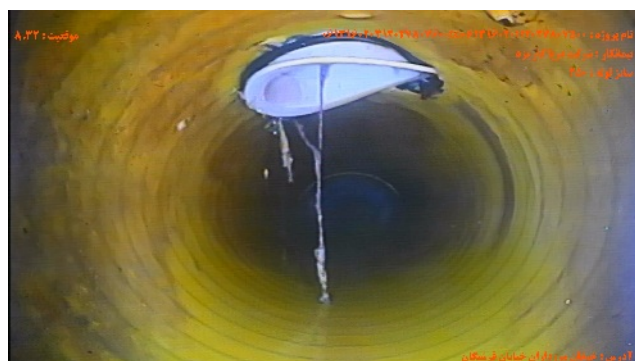
شماره تصویر ۴ عنوان موقعیت ۸.۳۲ کد CX اتصال جانبی معيوب / اتصال معيوب انشعاب
