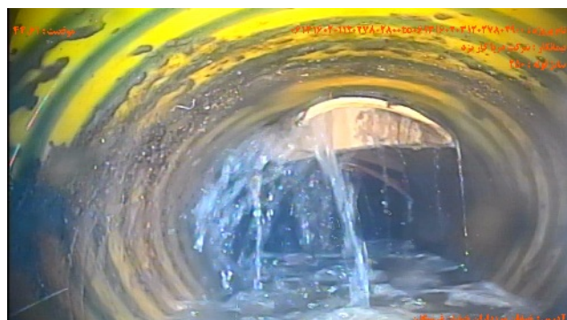
شماره تصویر ۶ عنوان موقعیت ۴۴.۶۱ کد محل اتصال انشعاب / اتصال انشعاب CN
