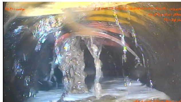
شماره تصویر ۸ عنوان نفوذ ریشه / نفوذ انبوه ریشه ها و گاهی سطح مقطع به میزان ۱۰ درصد موقعیت ۴۵.۳۱ کد RM
