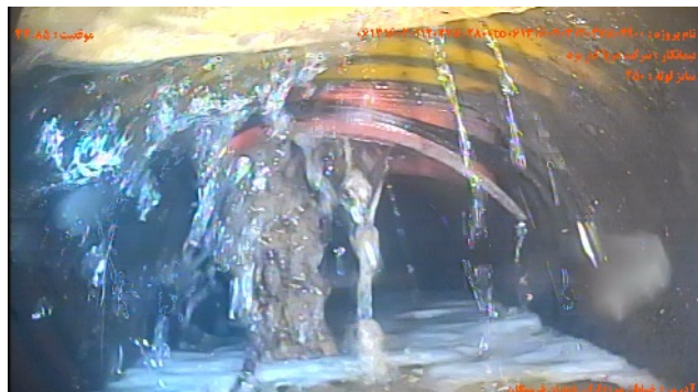
شماره تصویر ۷ عنوان اتصال جانبی معيوب / اتصال معيوب انشعاب موقعیت ۴۴.۸۵ کد CX
