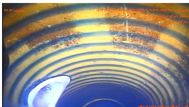
شماره تصویر ۹ عنوان محل اتصال انشعاب / اتصال انشعاب موقعیت ۴۶.۹۲ کد CN
